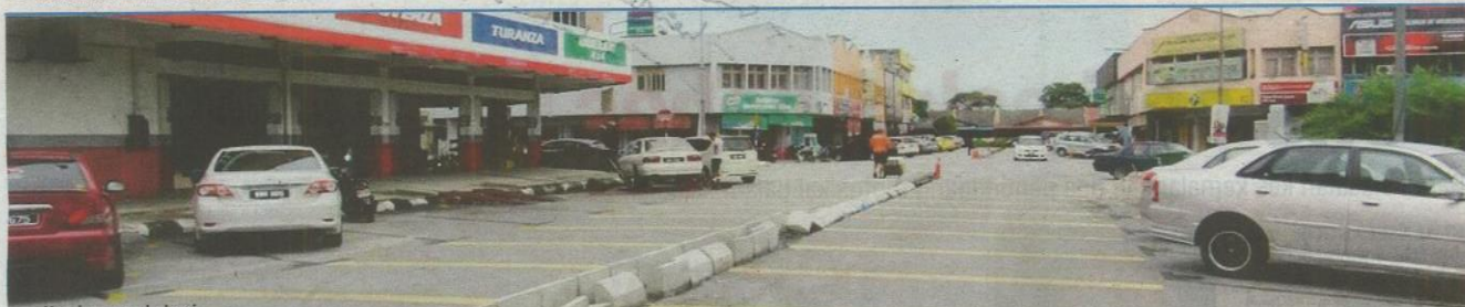
Keadaan pembahagi jalan sepanjang 150 meter di laluan Jalan Bunga Pekan 3.
